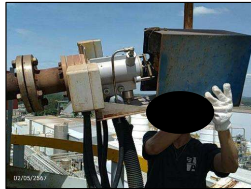
รูปที่ 2-2. การตรวจสอบดูแลซ่อมบำรุงเครื่องยนต์เครื่องจักร
