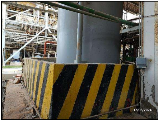
รูปที่ 2-28 กำแพงล้อมรอบถังเก็บสารเคมี
