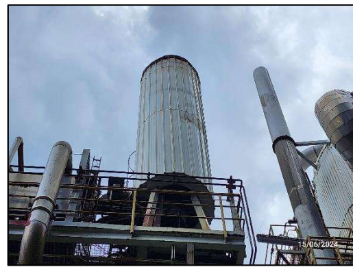
รูปที่ 2-17 ระบบควบคุมมลพิษทางอากาศ (Flare)
