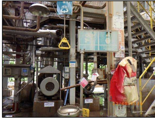
รูปที่ 2-31 ฝักบัวและอ่างล้างตาฉุกเฉิน
