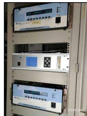
รูปที่ 2-4 เครื่องตรวจวัดคุณภาพอากาศอย่างต่อเนื่อง ที่ปล่อง Recovery Boiler
