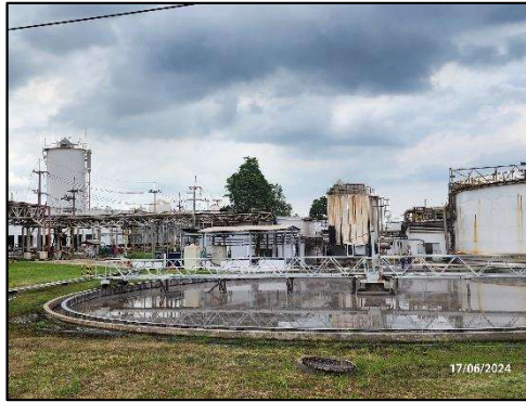
รูปที่ 2-7 ระบบบำบัดน้ำเสีย
