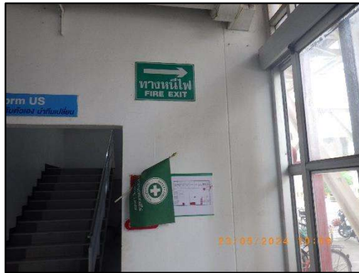
รูปที่ 2-37 ป้ายทางหนีไฟ
