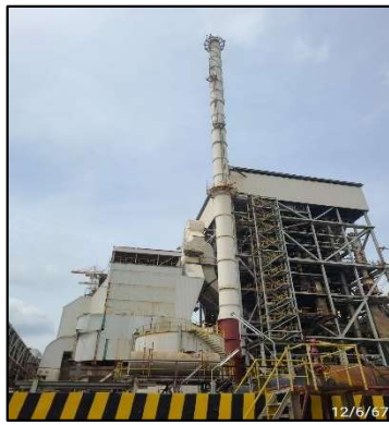
รูปที่ 2-16 ระบบควบคุมมลพิษทางอากาศ (Recovery Boiler Stack)
